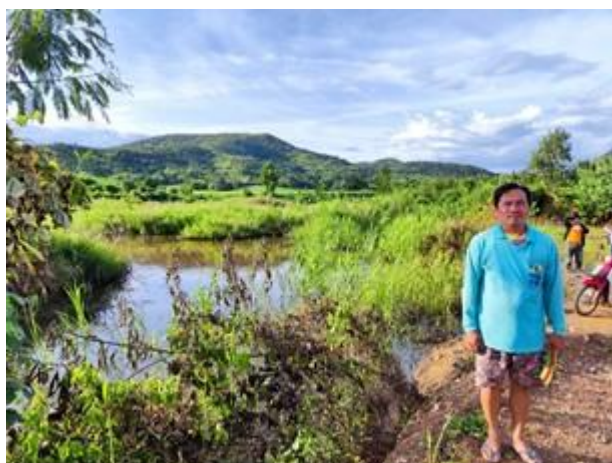
รูปภาพที่ ๖๕ โครงการขุดลอกสระเก็บน้ำสาธารณะ บ้านวังกกจาน หมู่ที่ ๓ (SPBW๖๕-๐๑๐)
